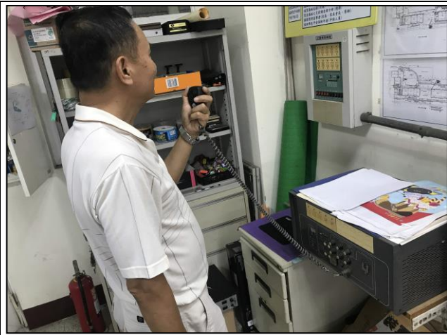
圖片說明：火警受信總機及災害警報廣播系統。
