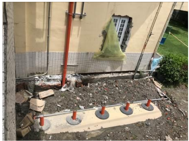
說明：安裝新化糞池。
