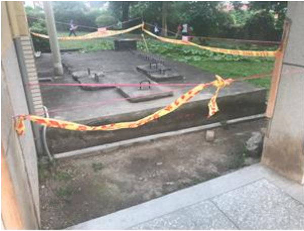
說明：施工前化糞池現況
