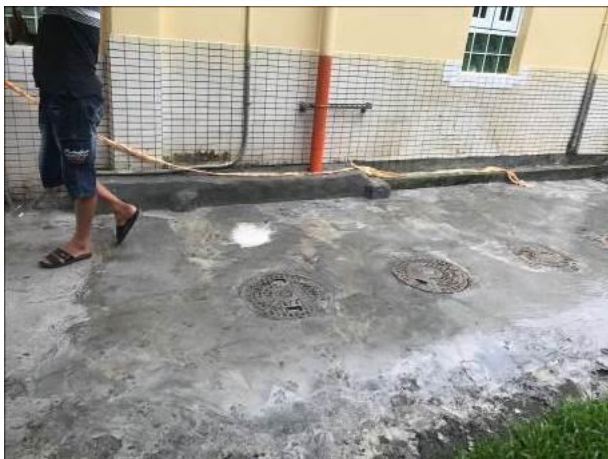
說明：化糞池安裝完成，地面填平。
