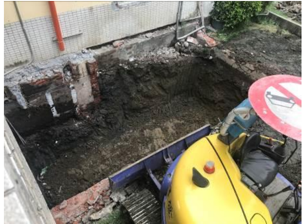
說明：施工前化糞池現況
