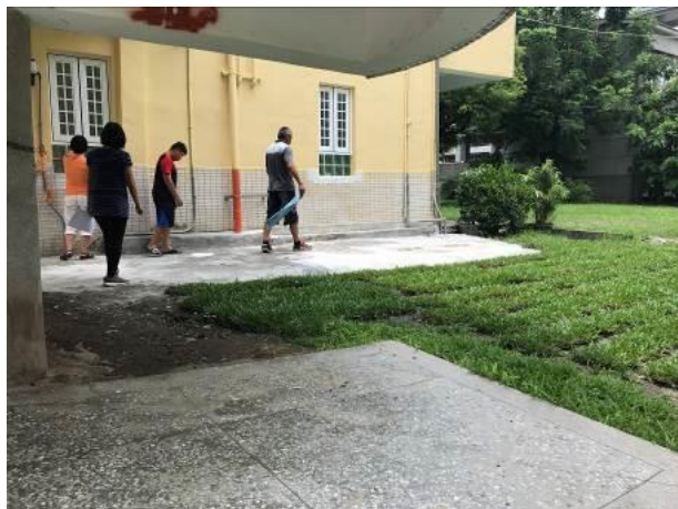
說明：化糞池安裝完成，驗收中。
