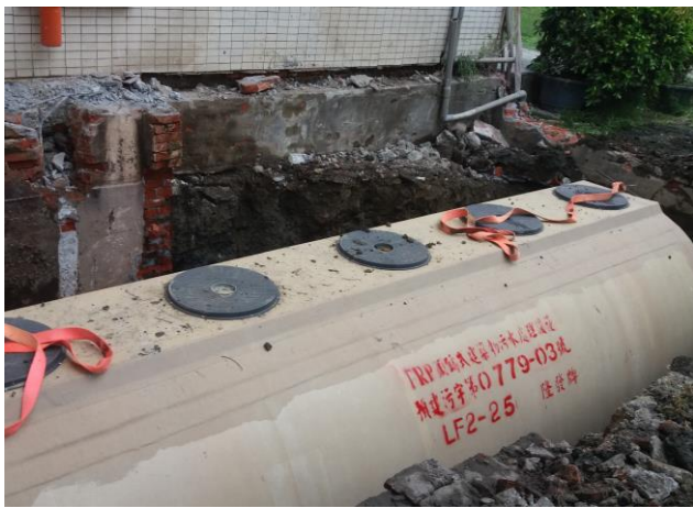
說明：安裝新化糞池。
